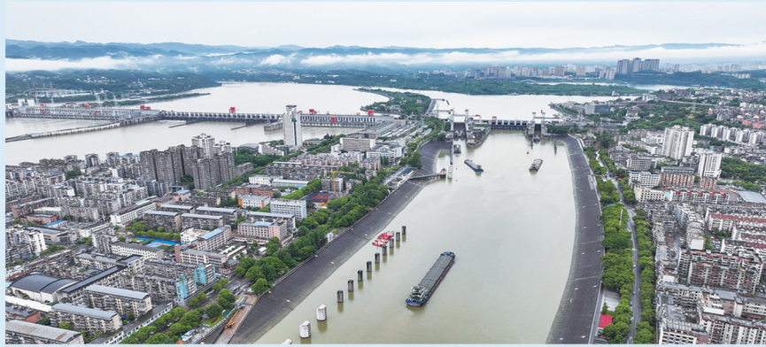
6月8日拍摄的三峡水运新通道工程葛洲坝航运扩能施工现场。 新华社记者 肖艺九摄
