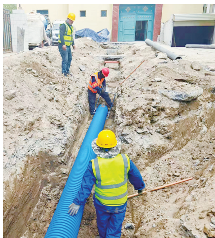
施工现场。记者张金凤摄
