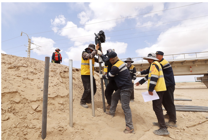
职工用打桩机打桩固脚。
