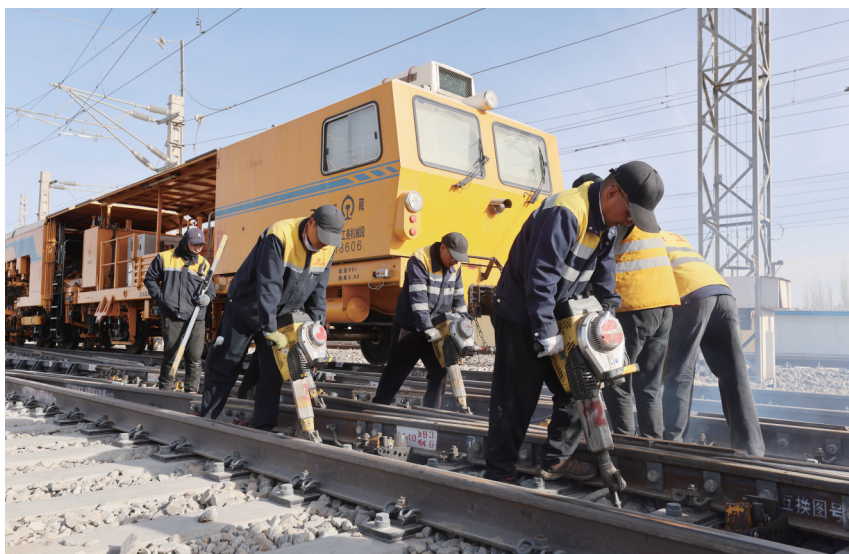
线路车间职工正在进行捣固作业。
