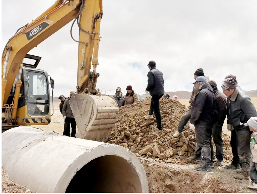
道路改造现场
