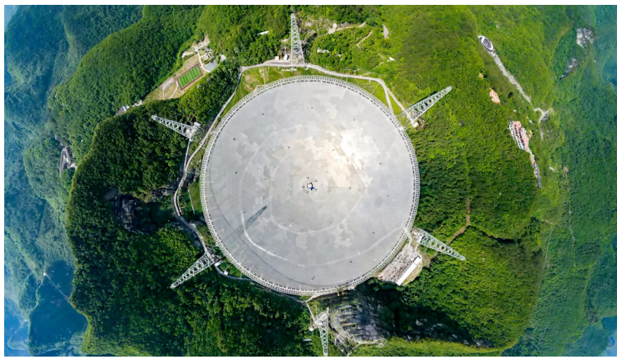
5月7日拍摄的“中国天眼”全景(无人机全景照片,维护保养期间拍摄)。
