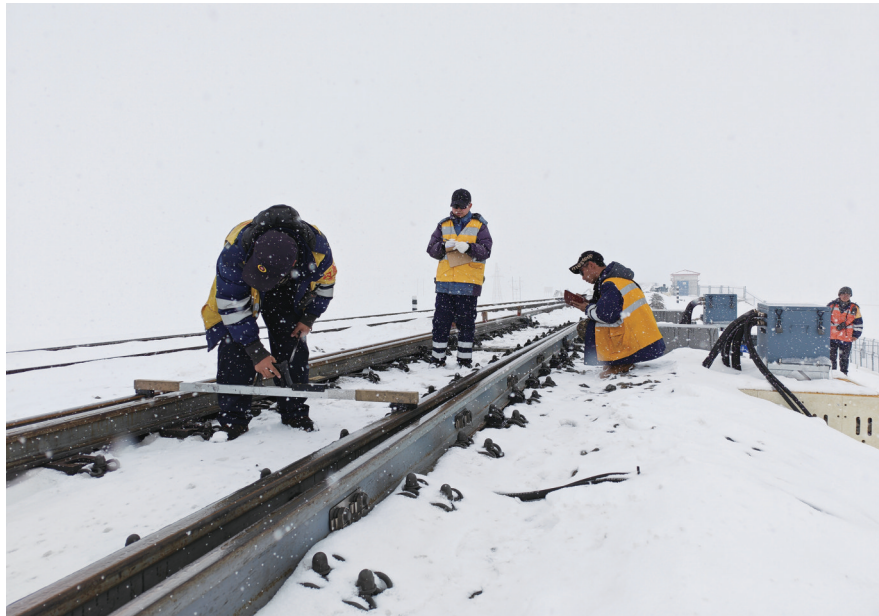
望昆线路车间职工踏雪进行维修作业。
