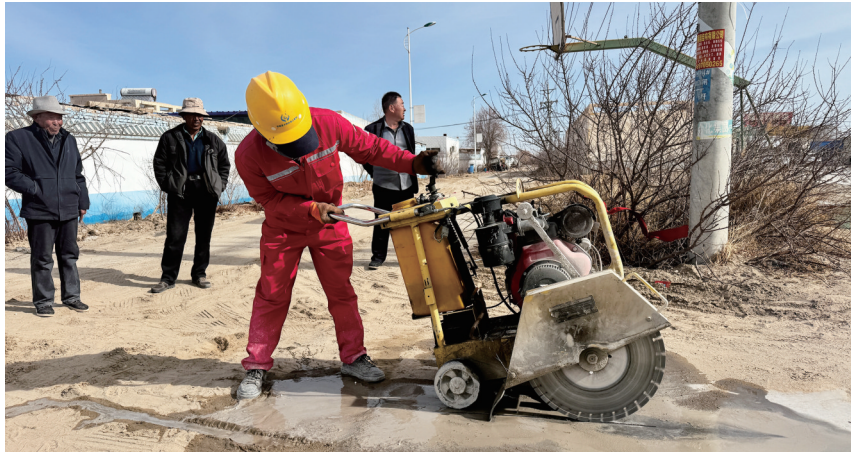
新乐村污水管网项目实施现场,施工人员正在切割地面。 记者 管晓静 摄
