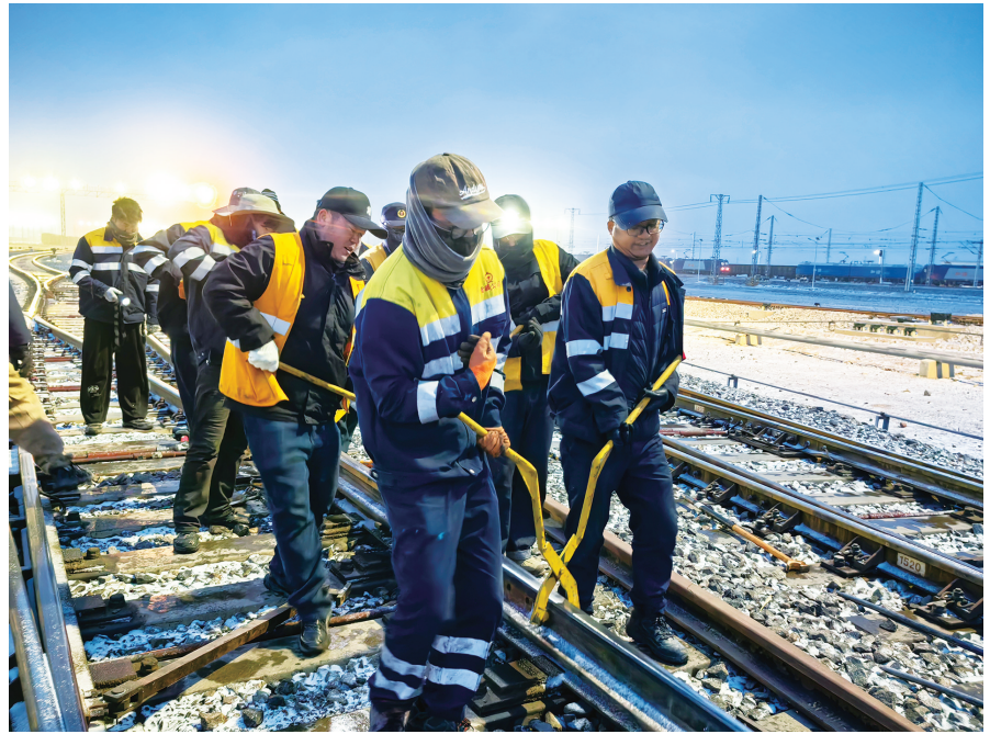
格尔木南线路车间职工正在对伤损的钢轨尖轨进行更换。通讯员 蒙文平 供图
