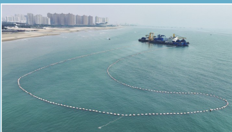
图为海缆敷设船抵达北海侧海域施工点，开展甩缆作业。(梁磊摄)
