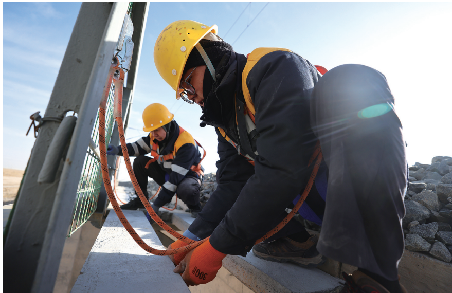
职工正在对新的桥梁步行板精准对位。
