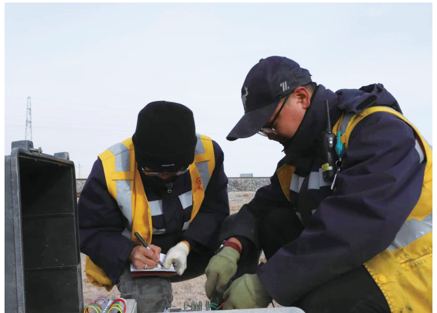
格尔木电务段职工在青藏铁路南山口站对铁路信号系统进行“全面体检”。
