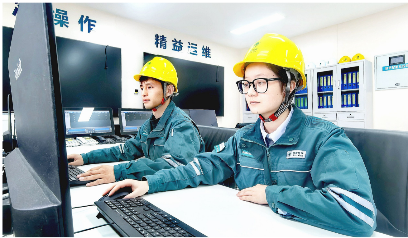
青海省电力公司超高压公司格尔木运维分部昆仑山750kV变电站工作人员春节期间坚守岗位。 记者 宗布尔 摄
