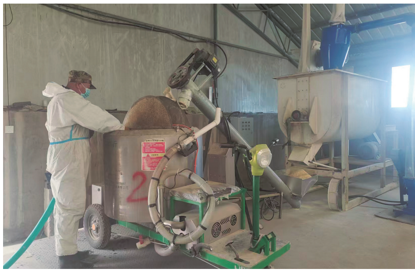
工人正在操作自动搅拌机。
