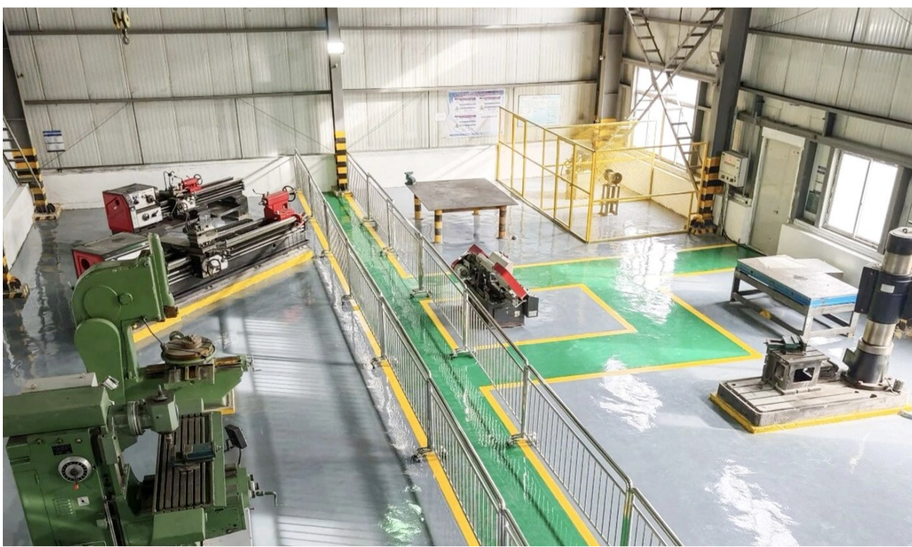
完成标准化提质升级的青海鸿鑫选矿厂机修车间。
