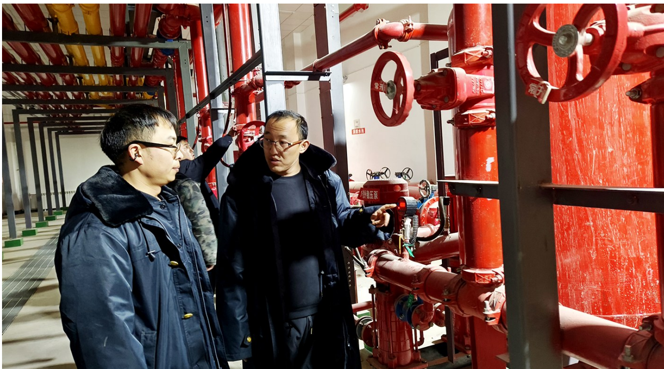
检查专班正在检查消防设施。
