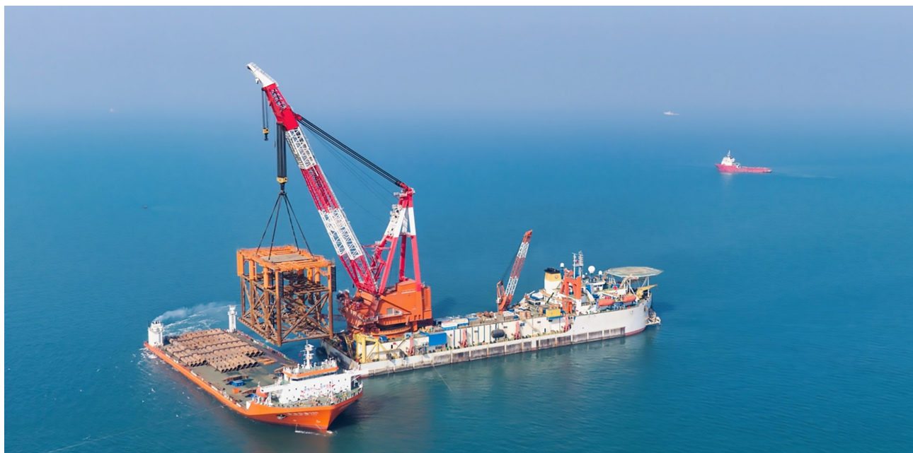
这是2月13日拍摄的渤中26-6油田开发项目(二期)导管架安装现场(无人机照片)。
