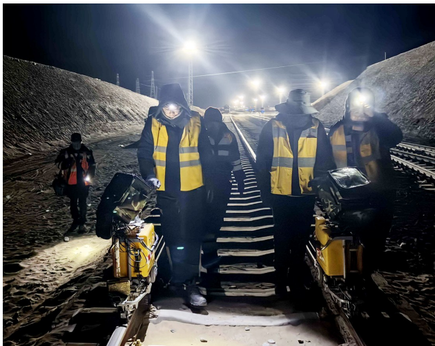
早上7点,格尔木工务段探伤工区职工利用天窗期紧张有序地进行探伤作业。
