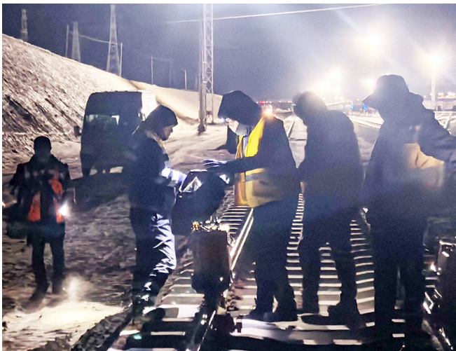
早上7点,格尔木工务段探伤工区职工利用天窗期紧张有序地进行探伤作业。
