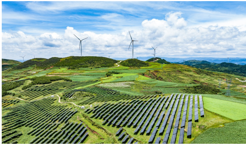
2025年7月3日拍摄的贵州金元仙水窝农业光伏电站一隅(无人机照片)。 新华社记者 陶亮 摄
