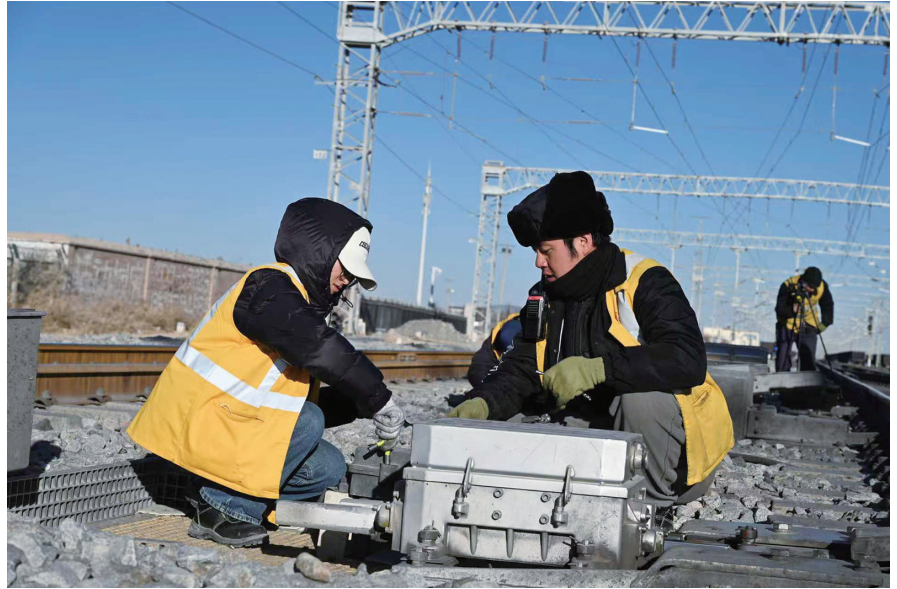
职工正在检修信号机和道岔。
