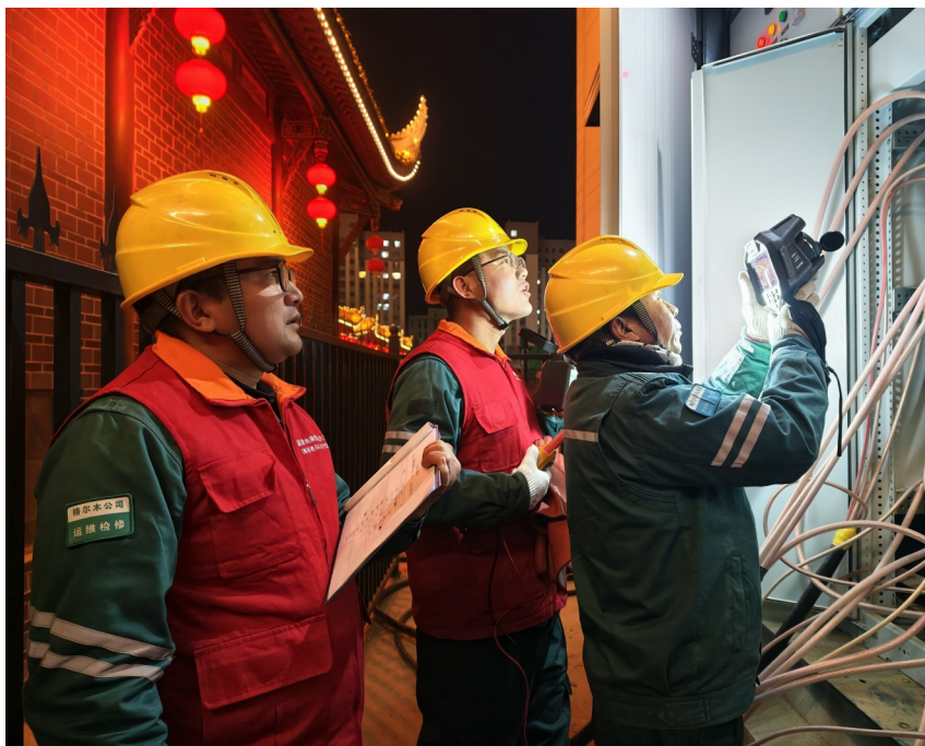
工作人员在10千伏泽六路昆仑天街台区测温、测负荷。
