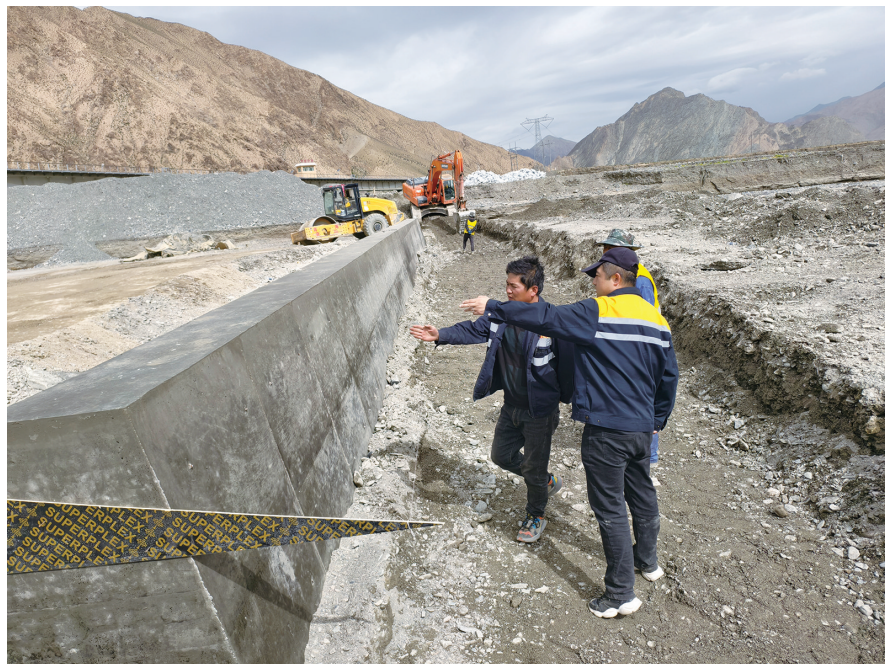
技术人员在河床边坡排查安全隐患。
