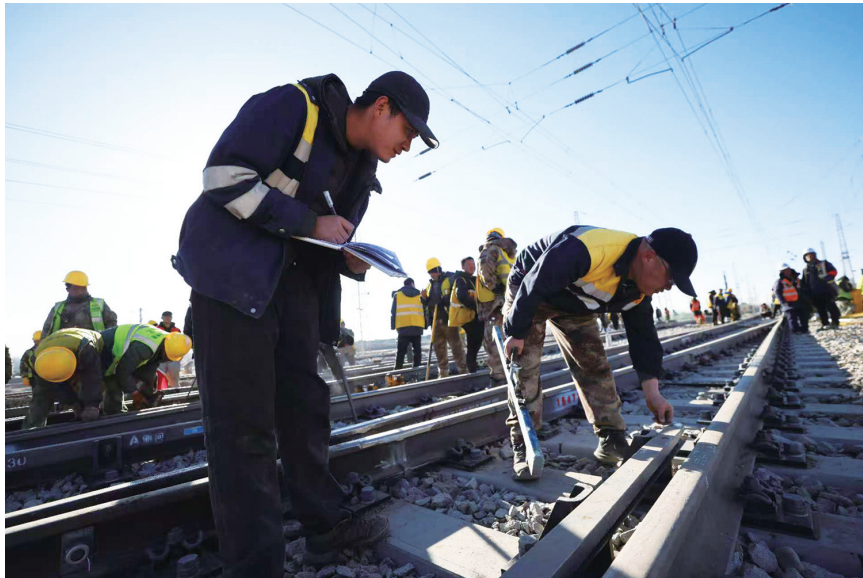
施工现场,机械轰鸣、人头攒动,一派热火朝天的繁忙景象。
