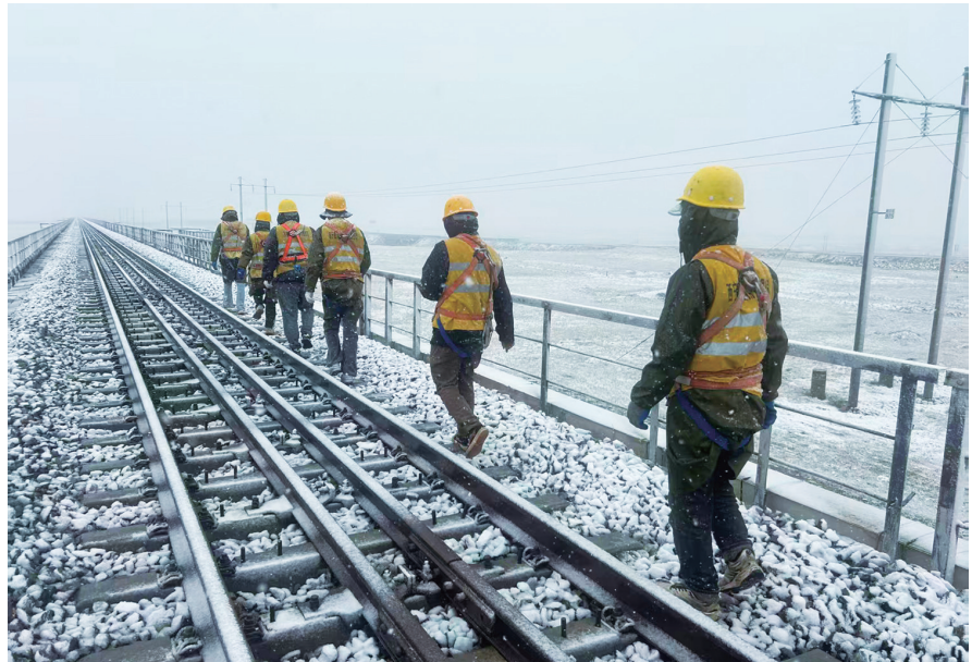
五道梁桥隧车间对桥梁步行板进行跟踪检查。
