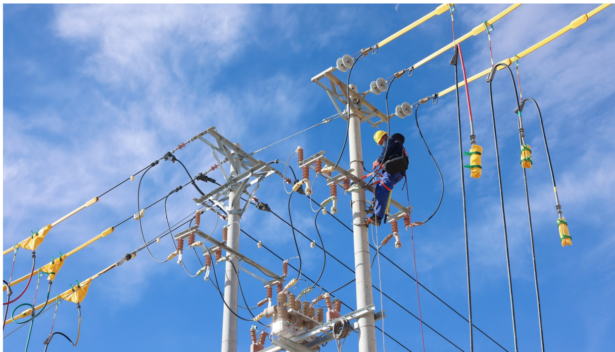
供电员工在20千伏鲁一路开展负荷切改作业。 海西供电公司摄
