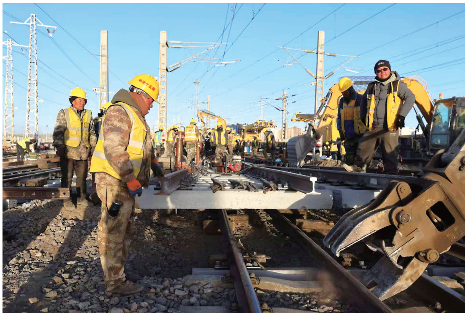
作业人员加紧换钢轨。
