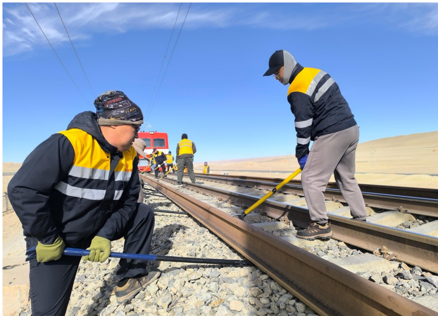
施工现场,工人用撬棍拨移钢轨。
