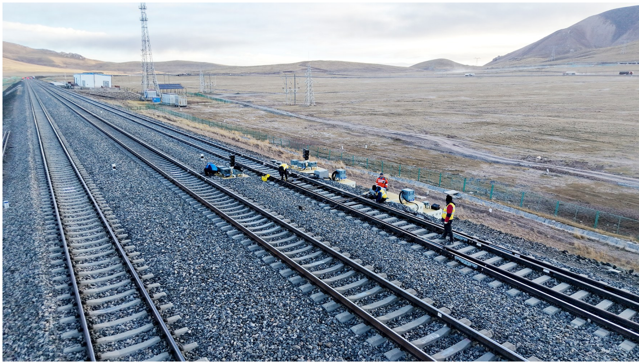
沱沱河信号工区的信号工们正在进行检修作业。
