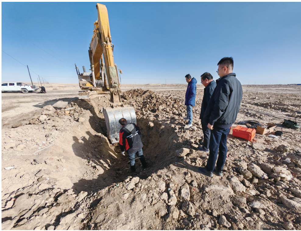
迁改工程施工现场。
