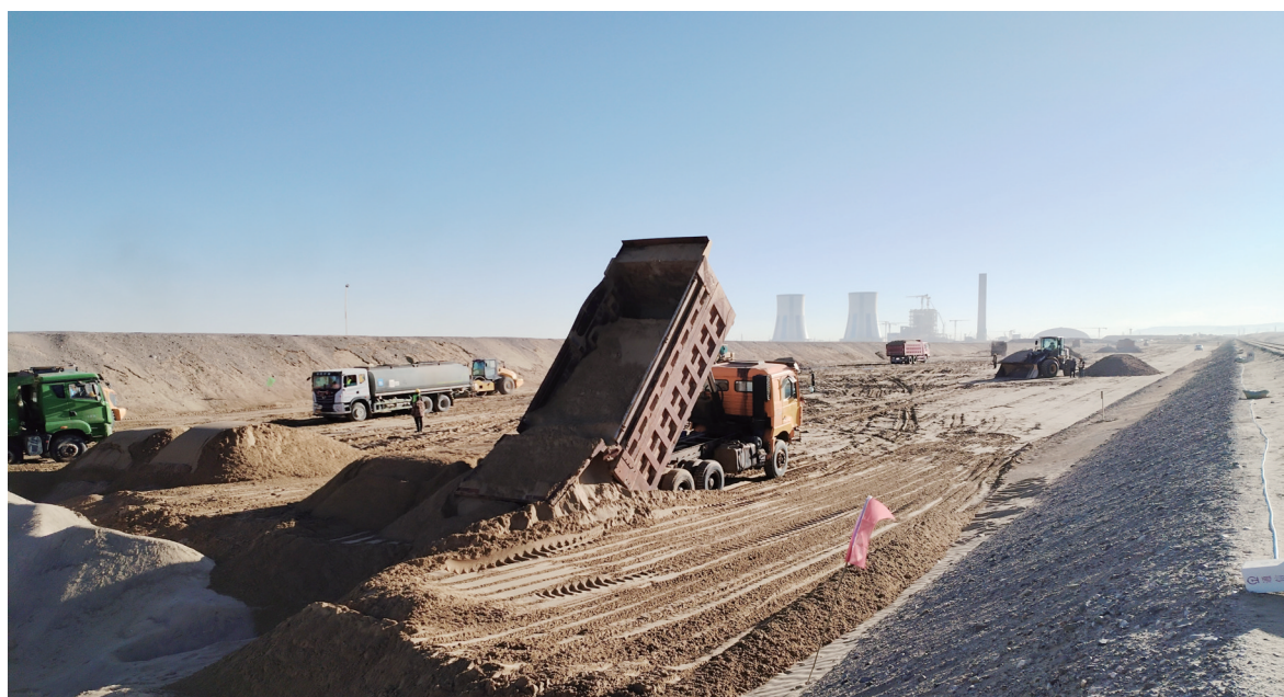
项目施工现场。
