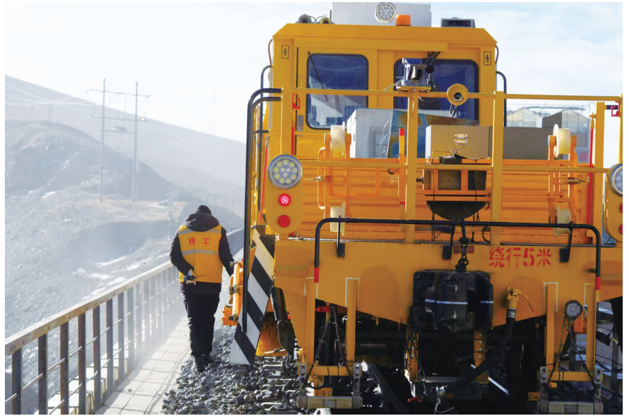
青藏铁路上捣固机正在进行捣固作业。
