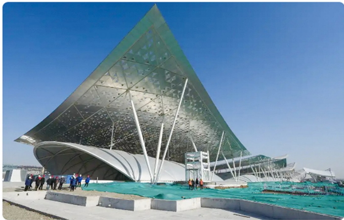
▲2月26日拍摄的北京城市副中心站综合交通枢纽工程和“京帆”屋盖。
