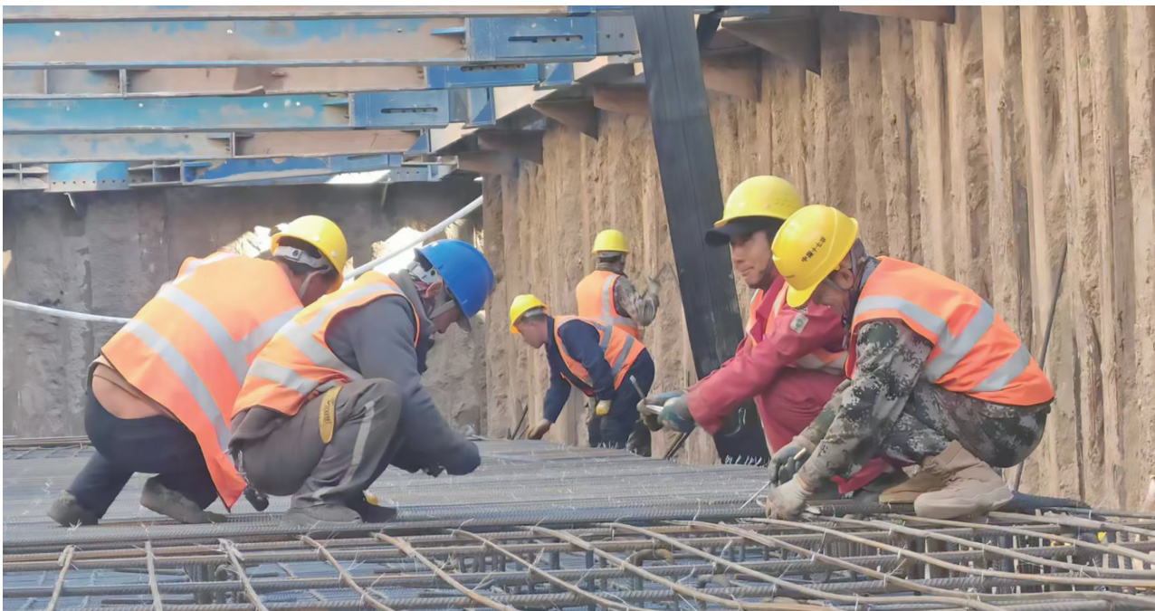
施工现场,工人正在加紧施工。
