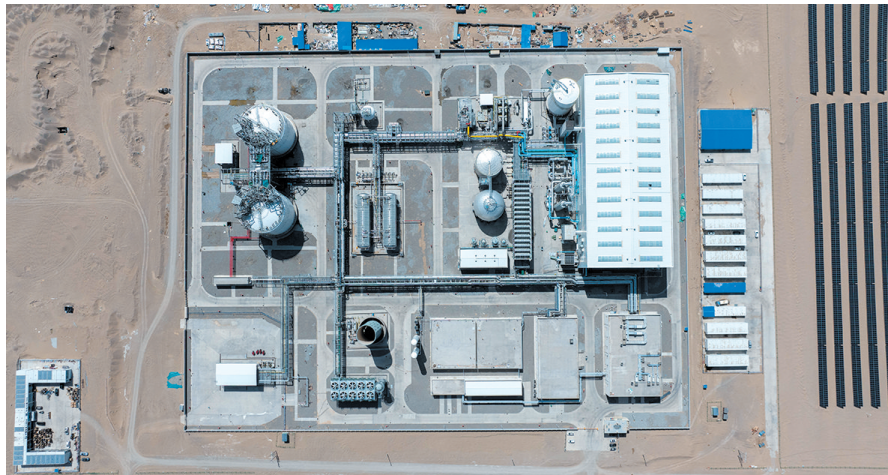
▲ 青海6万千瓦/60万千瓦时液态空气储能示范项目。
