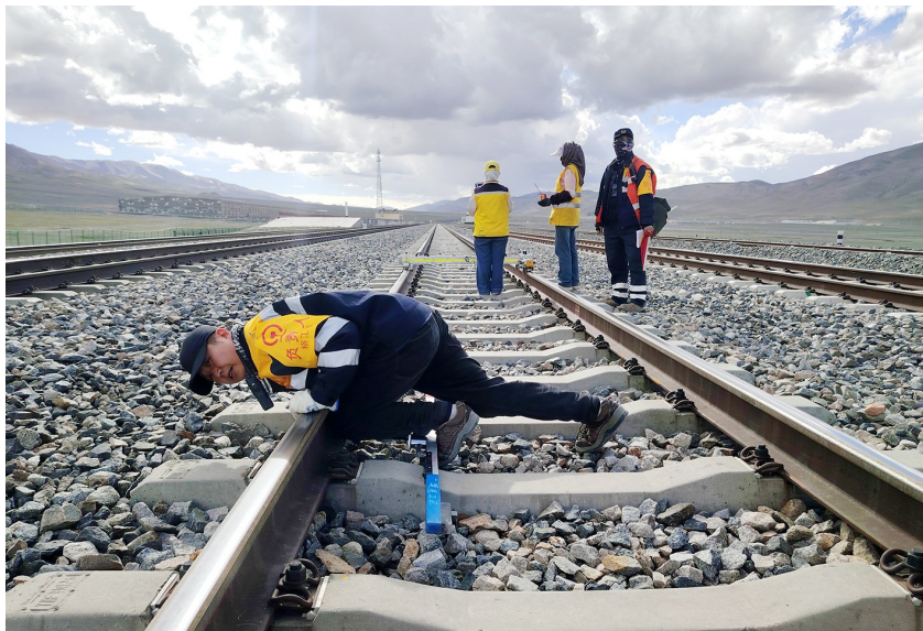
一名职工正在用轨检小车测量钢轨水平数值。
