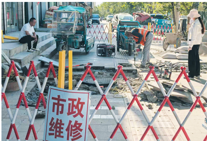
工作人员正在修复破损井盖及周边路面。
