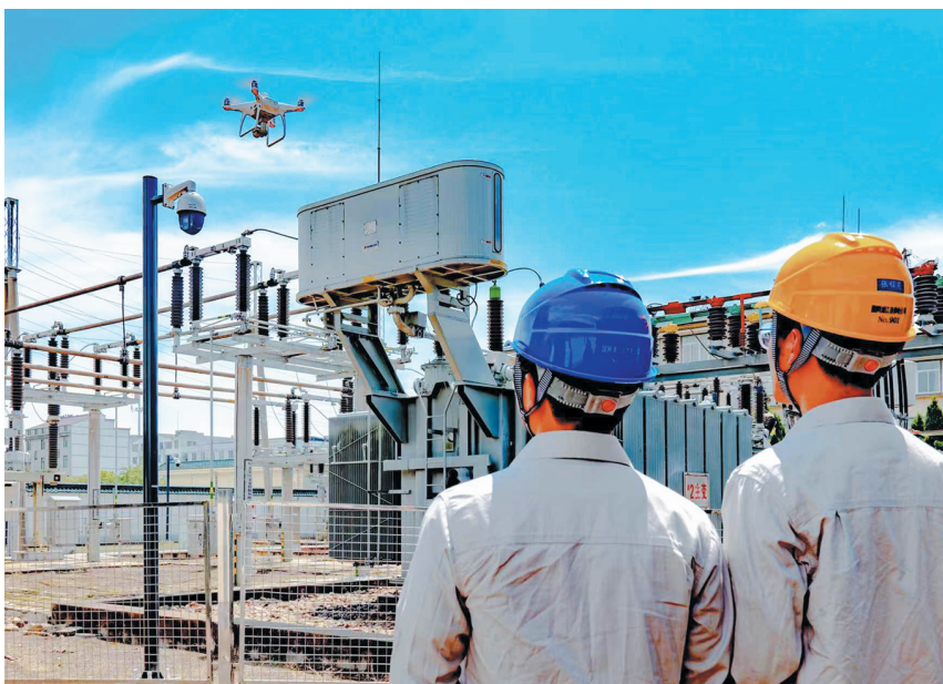
8月,国网金华供电公司工作人员对110千伏黄宅变电站及周边输电线路开展一体化巡检,保障迎峰度夏电网安全运行。(受访单位供图)
