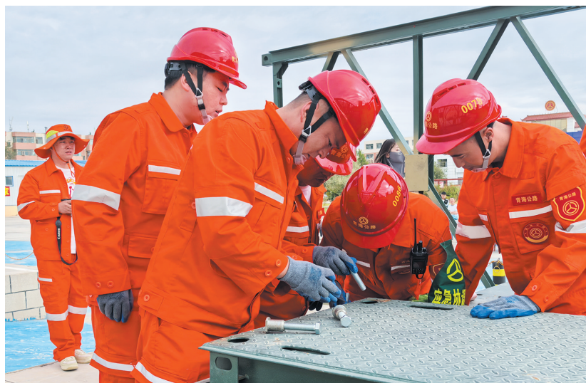
钢桥架设应急演练现场。
