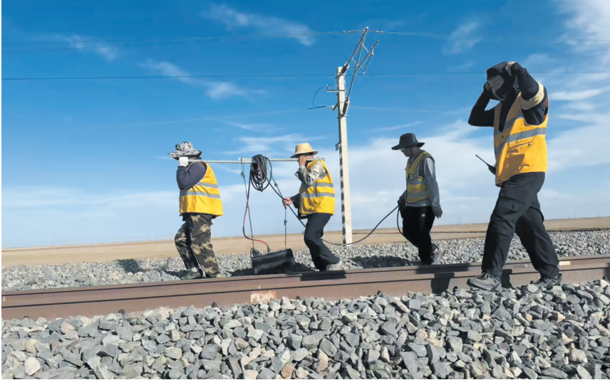
格尔木工务段工作人员正在对盐湖路基进行地质探测。 通讯员 蒙文平 摄
