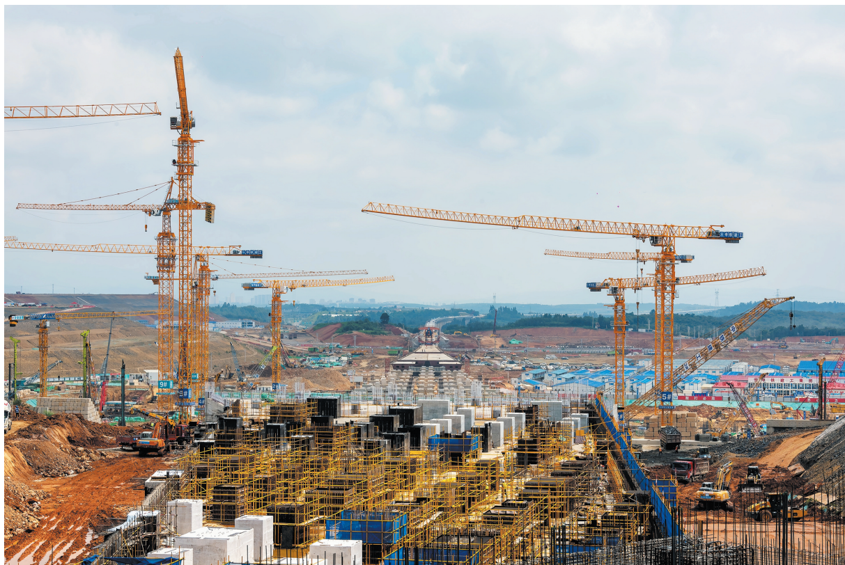
渝昆高铁长水机场隧道进口端施工现场。
