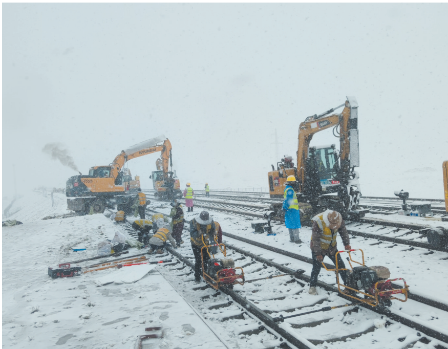
格尔木工务段望昆线路车间职工正在冒雪换轨。
