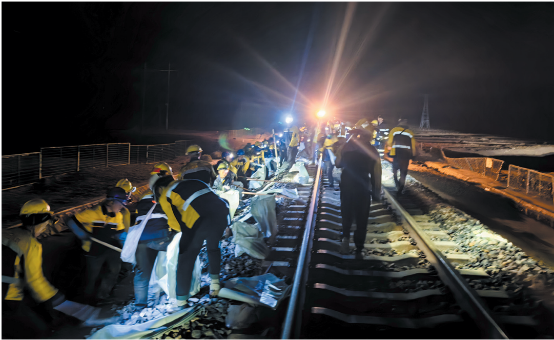
格尔木工务段职工正在对水害地段和冲刷道床进行抢修作业。 通讯员 蒙文平 摄
