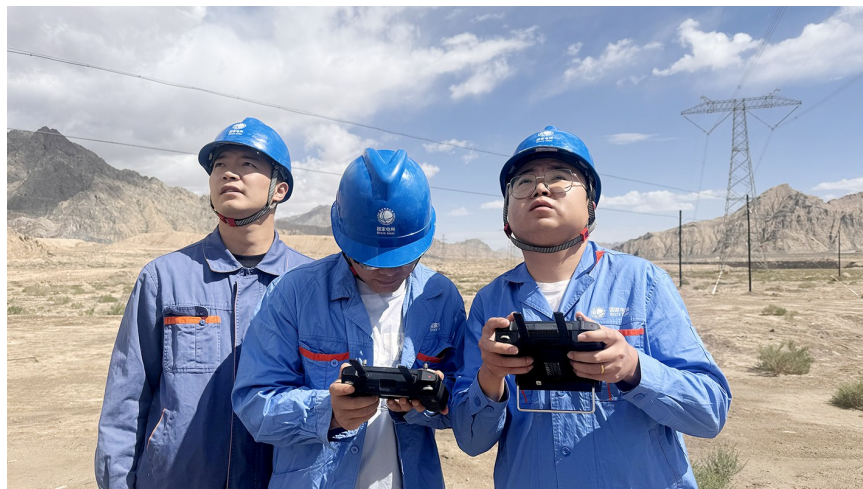
运维人员正在使用无人机安装防外破装置。
