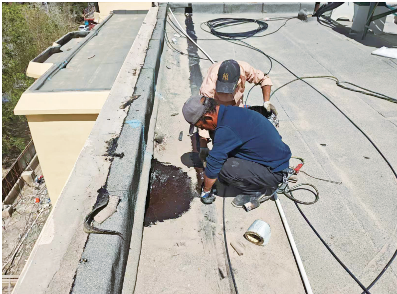
房顶修复现场。
