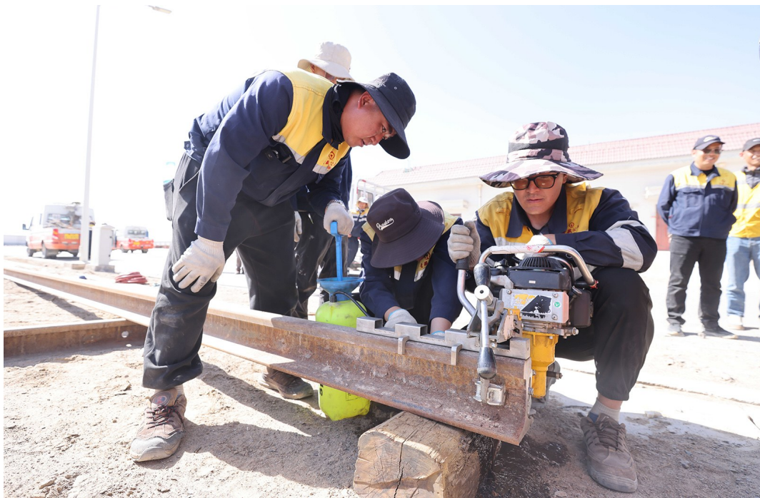
职工正在演练钢轨钻眼打孔操作技术
