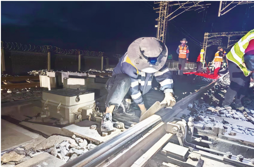
职工何江东正在调试道岔杆件。
