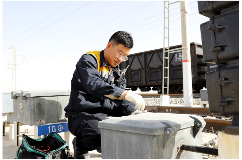
郭占博正在检查轨道箱盒。 通讯员 赵辉 摄
