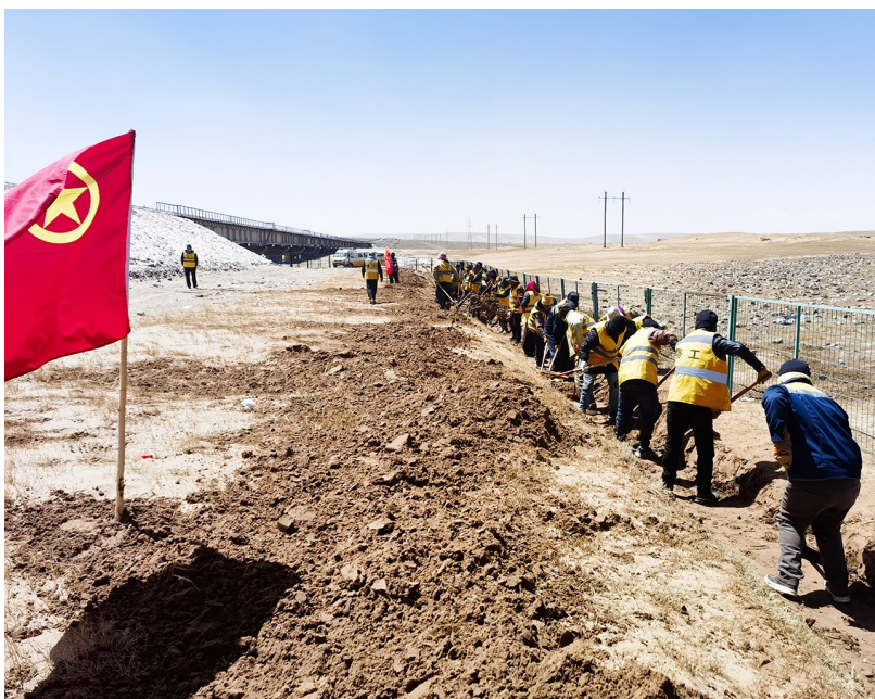
工务段职工清理排水沟淤泥。
