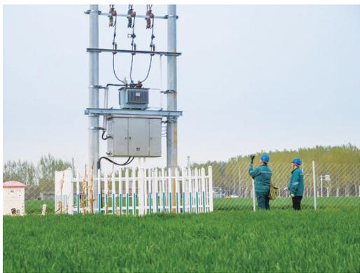
图为国网滨州邹平市供电公司工作人员在无人智慧农场巡检农排变压器等供电设备。(受访单位供图)
