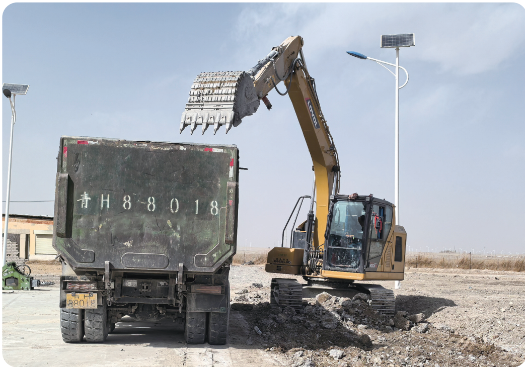
大型机械在小岛村开展作业。
